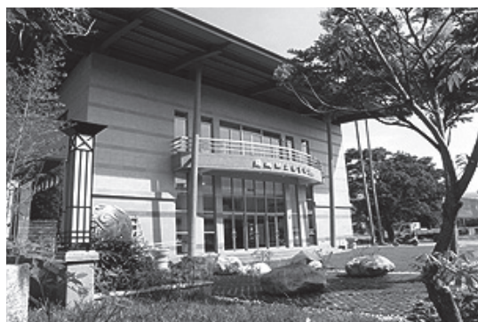
頭城鎮立圖書館新建館舍（98.7.25）
