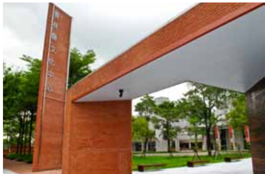
雲林縣文化中心修繕後大門的全新面貌
