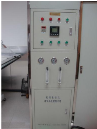
文獻保護修復部：淨水設備
