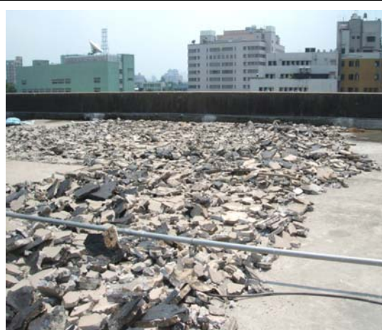
屋頂舊有面層打除
