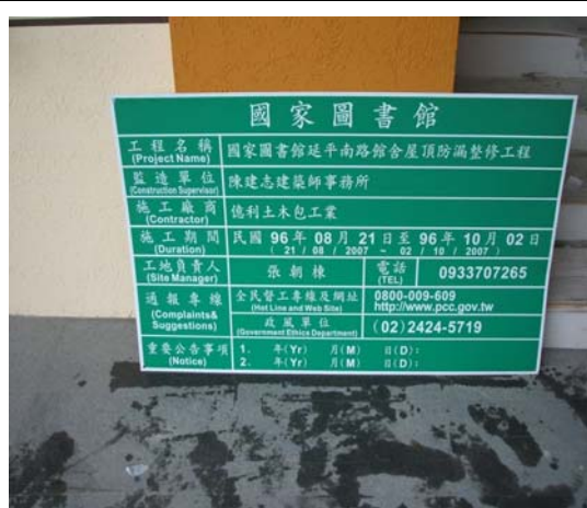
屋頂防漏整修工程施工公告牌
