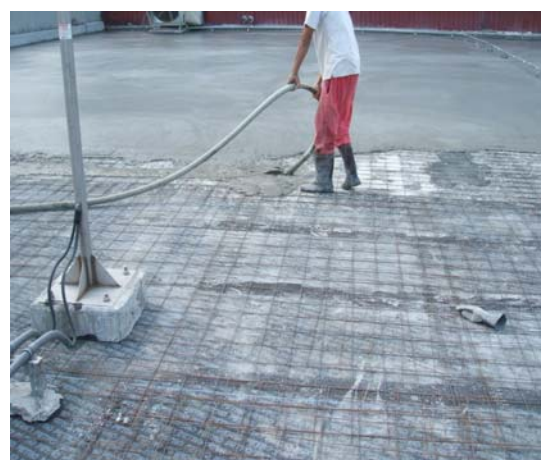
澆置泡沫混凝土
