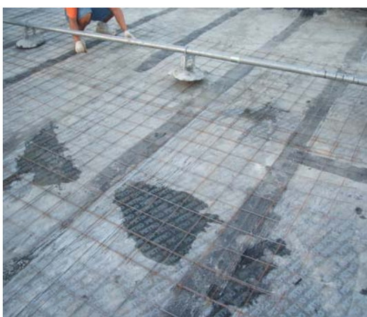
鋪設點焊鋼絲網
