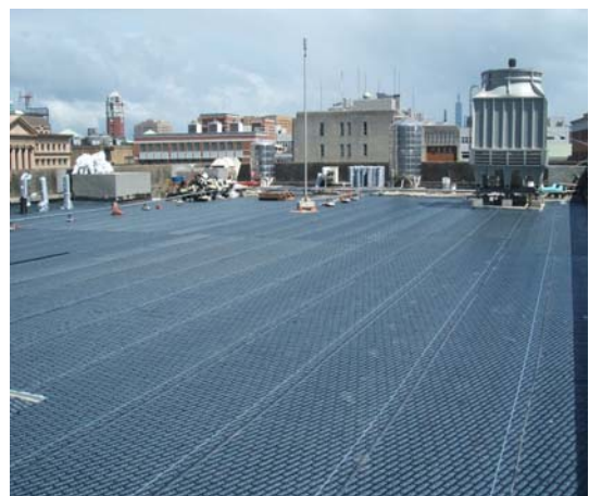
自黏式防水膜鋪設完成
