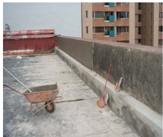
女兒牆壓簷砌磚面粉光
