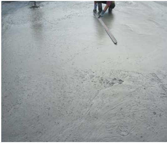
泡沫混凝土整平
