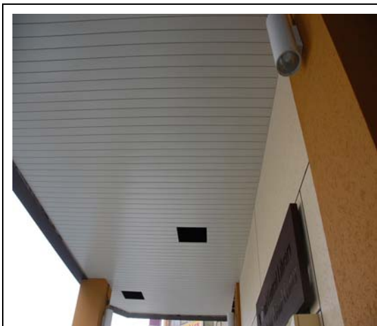
騎樓及家具設備整修工程
