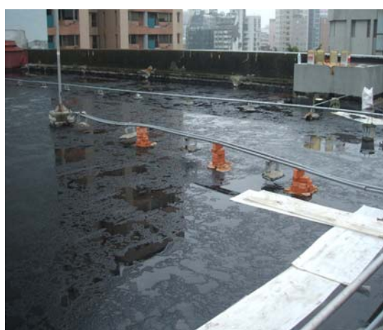
底油及熱熔膠施做後遇連續大雨
