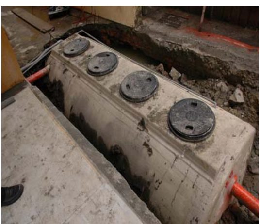
FRP 化糞池安裝
