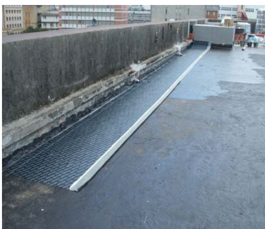
熱熔膠及自黏式防水膜
