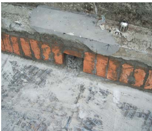
女兒牆壓簷砌磚(落水頭處)
