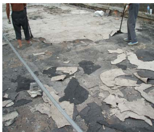
舊有防水層鏟除
