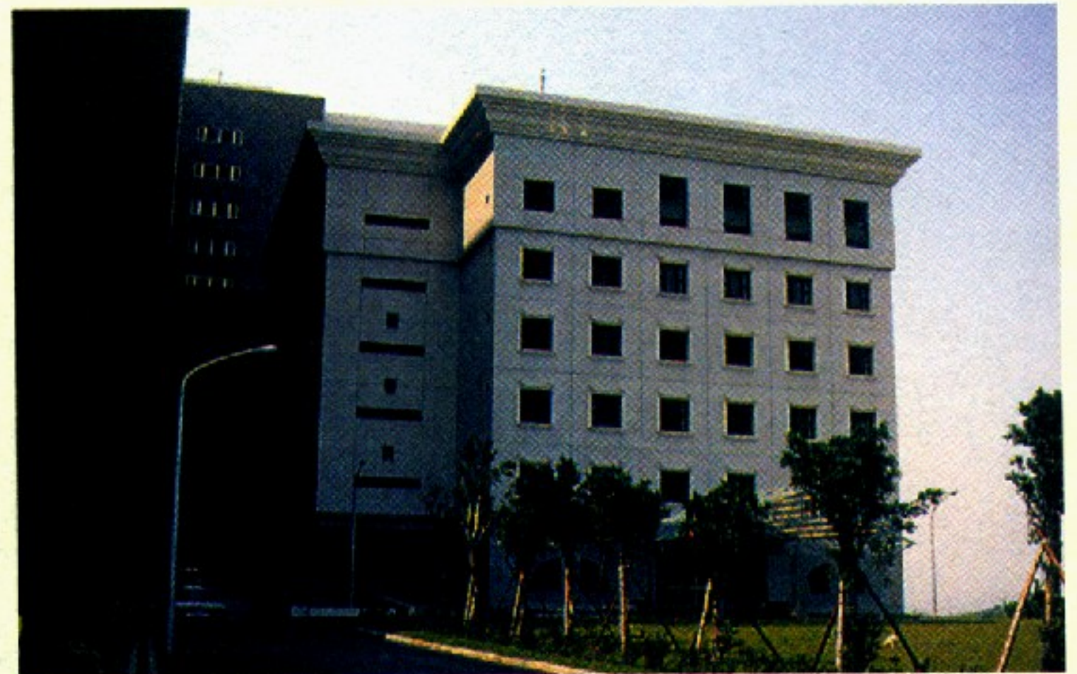
■ 長庚大學圖書館 ④ 桃園縣龜山鄉文化一路259號 ⑤ 民國85年10月啓用 ⑥ 獨立館舍，使用面積9,984 (m 2 ) ⑦ 陳永全建築事務所設計興建 ⑧ 游玉芬攝影
