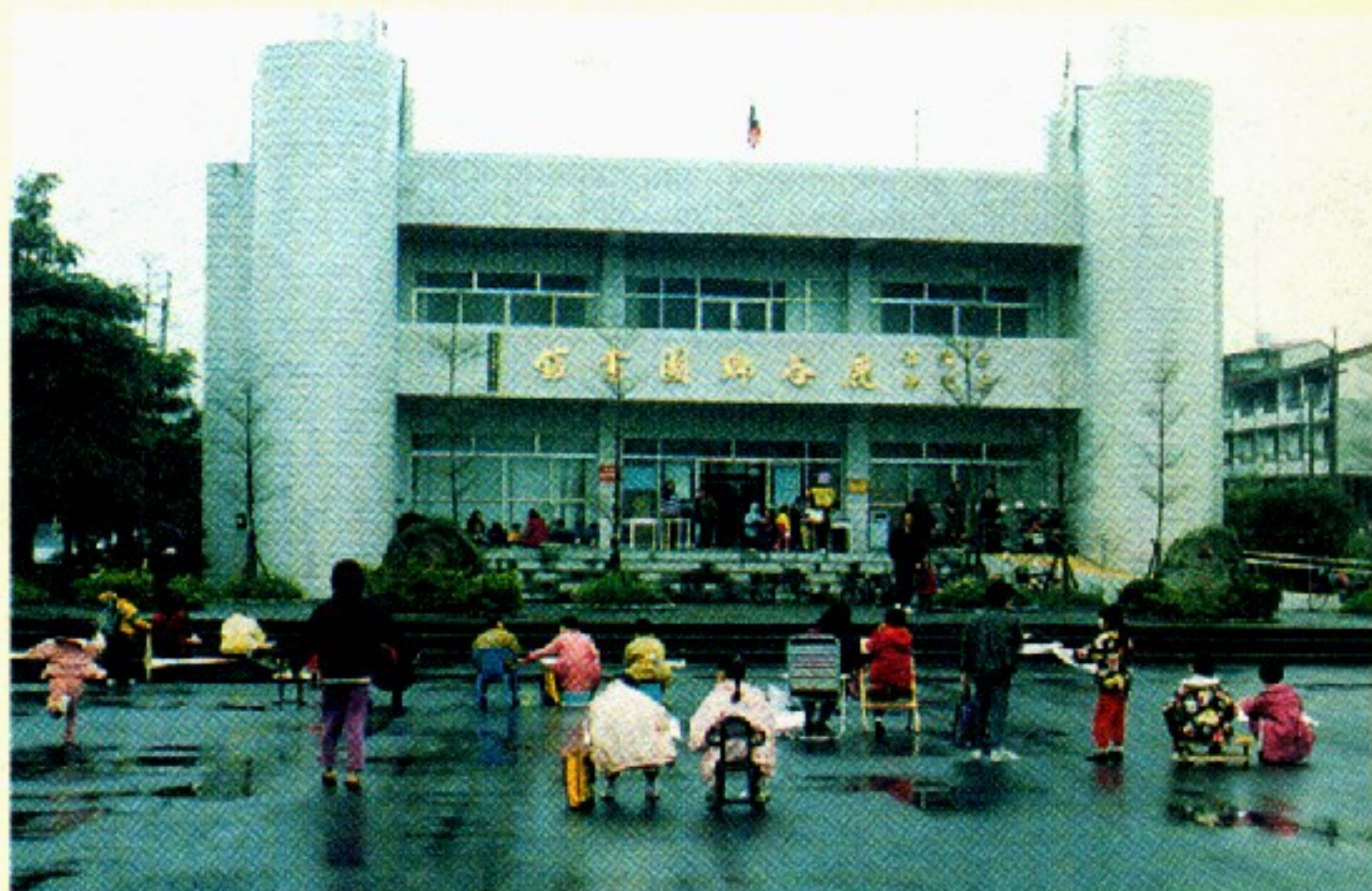
■ 南投縣鹿谷鄉立圖書館
