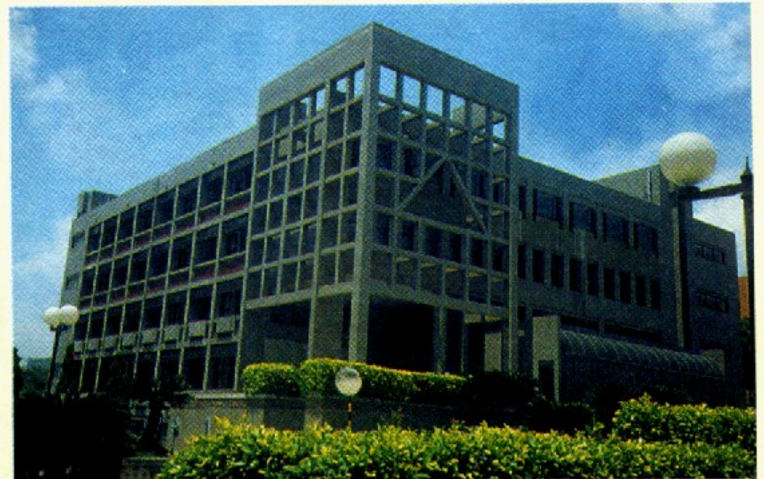
■ 靜宜大學蓋夏圖書館 ④ 臺中縣沙鹿鎮中棲路200號 ⑤ 民國77年3月14日啓用 ⑥ 獨立館舍，使用面積7,852 (m 2 ) ⑦ 唐真真建築師事務所設計興建
