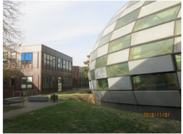
圖書館的行政區過地下通道與本館連接
