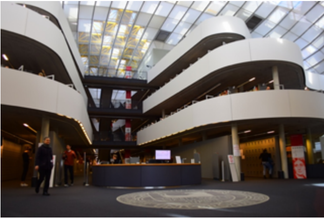
圖書館內部建築為鋼筋水泥結構，地面上的樓層為平臺式設計，與建築物的外殼並不相互接觸
