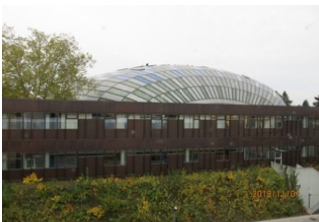
圖書館位於「鐵鏽小屋與白銀小屋」的中庭之內
