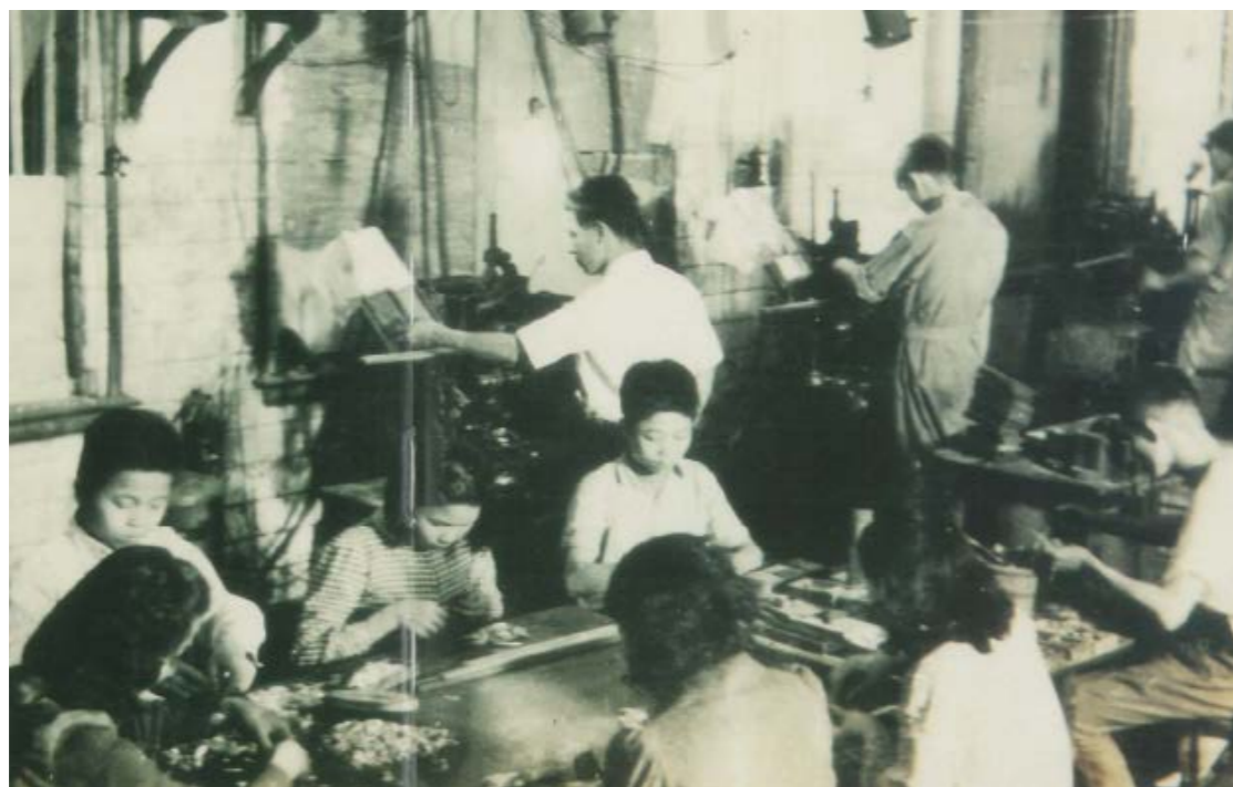
圖片說明：約1940年代的鑄字房內，鑄好的字需要人工以剉刀整平毛邊。
