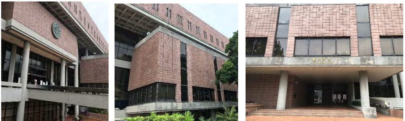
東向立面外牆磁磚現況
