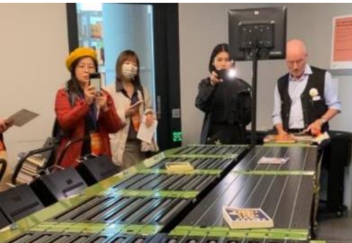
自動分揀輸送設備貫穿整棟建築物
