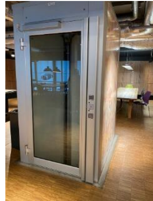
館內單獨設置的無障礙電梯
