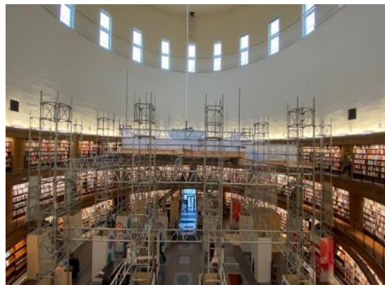
大廳圓弧狀藏書區 (現正進行吊燈維修工程)
