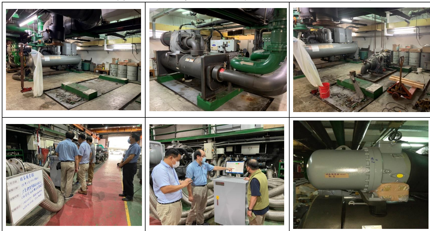
空調主機系統設備汰換節能改善工程(施作、廠測及竣工驗收照片)
