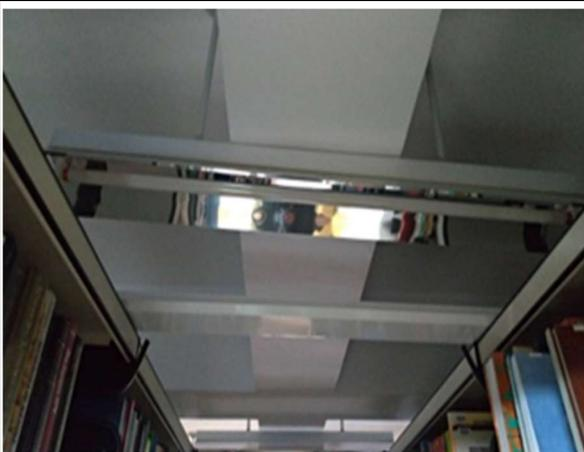
完成後:LED 工事燈/懸吊式 13W
