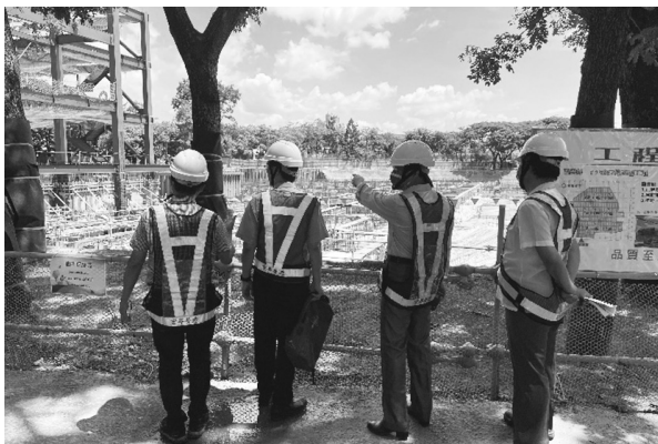
教育部施工查核小組委員至工程現場查核施工品質（112年7月21日）
