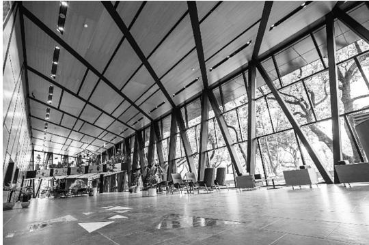
圖 12 屏東縣立圖書館總館整建後新大廳以連續 V 型鋼構呼應戶外植栽樣貌
