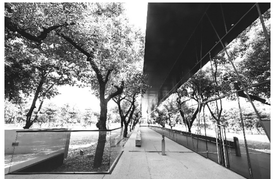
圖 11 屏東縣立圖書館總館整建後新大樓長廊以玻璃帷幕映照出戶外綠景
