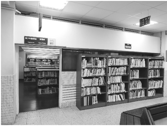
圖 9 屏東縣市立圖書館總館整建前三樓夾層高度低矮，具有壓迫感
