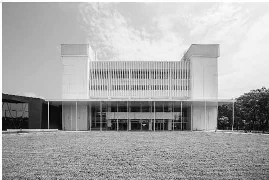
圖 10 屏東縣立圖書館總館整建後南向入口以草坡取代原有硬鋪面廣場
