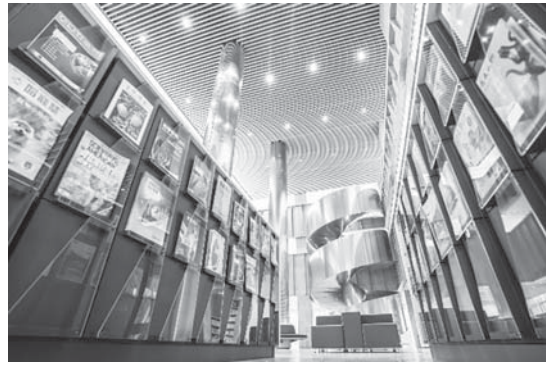
圖 13 屏東縣立圖書館總館整建後圖書館大廳新設旋轉梯，以不鏽鋼板包覆原有結構柱
