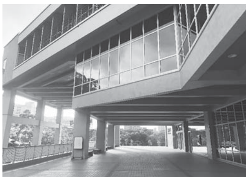
樑柱為清水面混凝土
