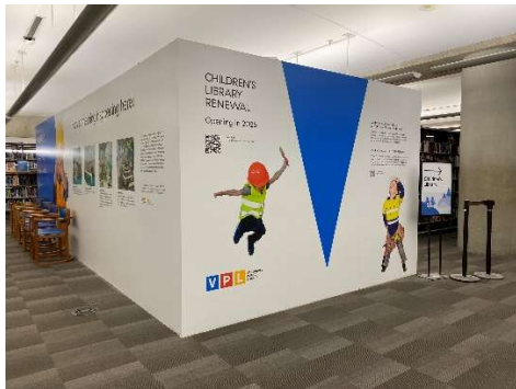
2樓兒童圖書館改造工程看板
