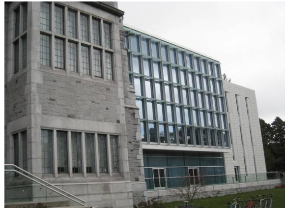
學習中心北翼外觀，中間玻璃格狀牆內即為 ASRS 系統
