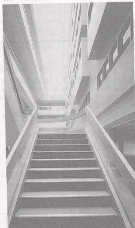
支字樓梯仰視
